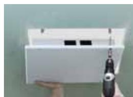
Lautsprechersystem einsetzen und verschrauben...
